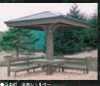
●浜中町 湯涌シェルター
