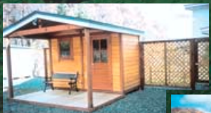
●函館市 O邸作業小屋
