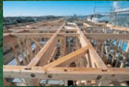
●道立技術専門学校 機設棟
