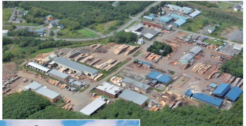
浜中町木材プラント
